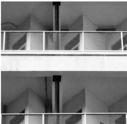
En las naves destinadas a la hospitalización pueden apreciarse giros zigzagueantes con técnica de protección solar a manera de tapa sol o brisolei
